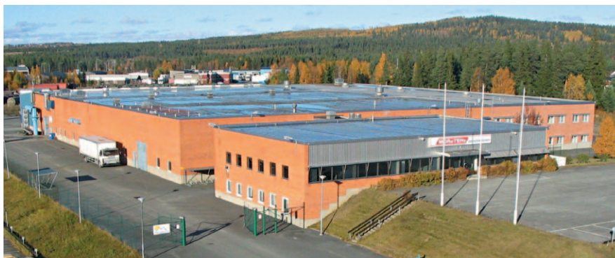
L'usine MORETENS à Östersund
